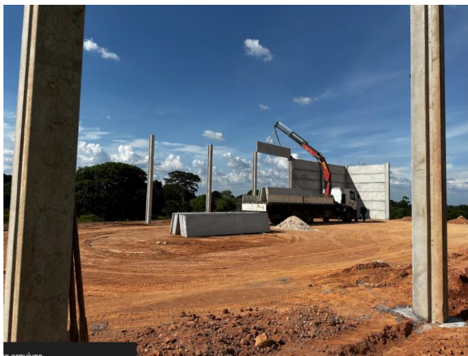
Figura 9 - Estrutura pré-moldada
