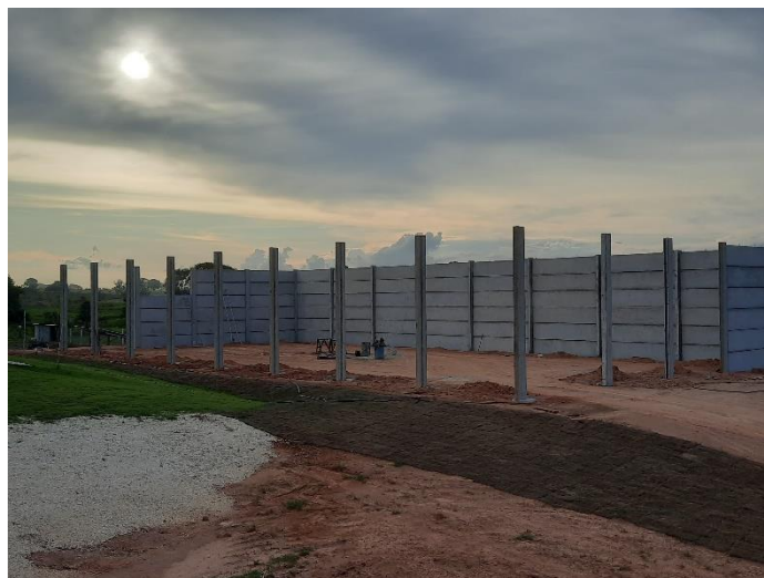
Figura 7 – Pilares estrutura pré-moldada
