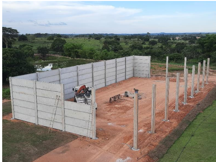
Figura 6 – Estrutura pré-moldada
