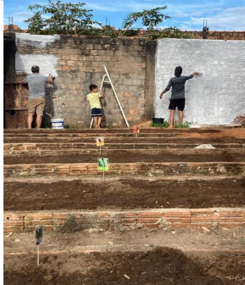
Figura 16 – Dia 2: Aplicação de Cal nas paredes
