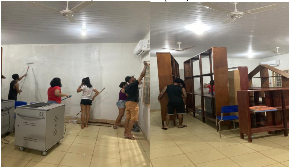
Figura 3 – Dia 3: As paredes foram lixadas e pintadas de branco para amenizar fissuras, furos de parafusos e outras imperfeições
